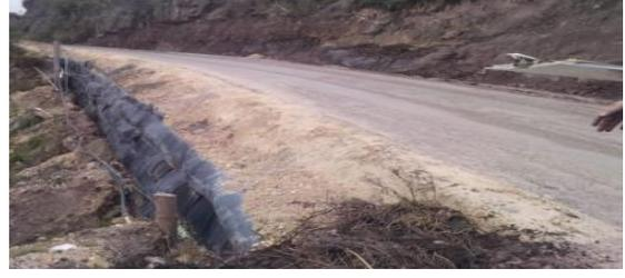
**Foto 23** Fresado estabilizado deteriorado.
