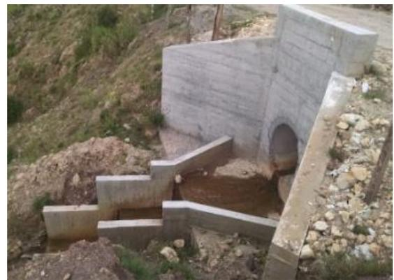
**Fotos 19 y 20.** Construcción de Alcantarillas (Ver CD Anexo con las 9 unidades).
