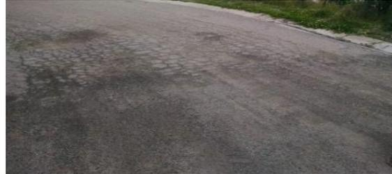
**Fotos 24 y 25.** Fresado estabilizado en estado de deterioro.
