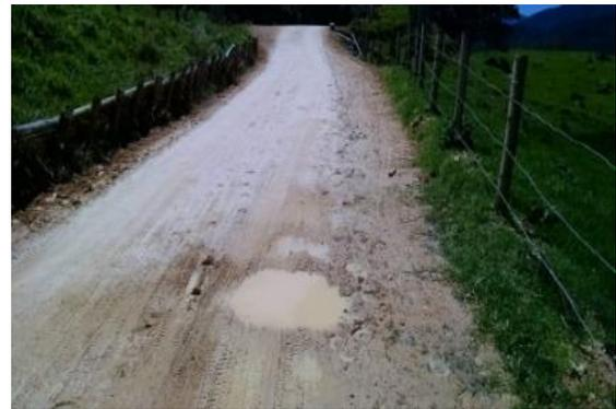
**Fotos 17 y 18.** Estructura de la capa granular en estado de deterioro.
