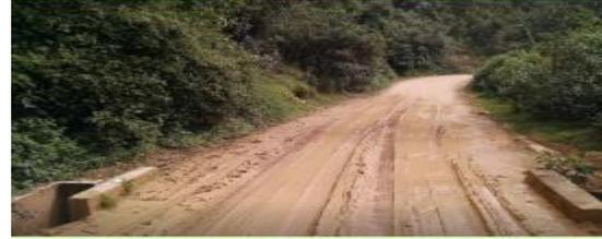
**Fotos 5, 6 ,7 y 8.** Estructura de la capa granular en estado de deterioro.
