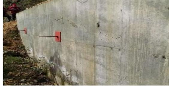
**Foto 1 y 2.** Muro de contención en concreto reforzado - Estado terminado.
