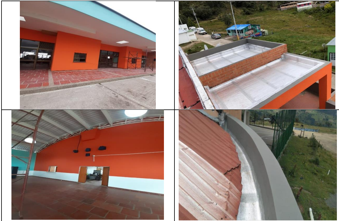
Frente de obra: Salón Comunal Mario Upegui, Corregimiento de San Juan.
