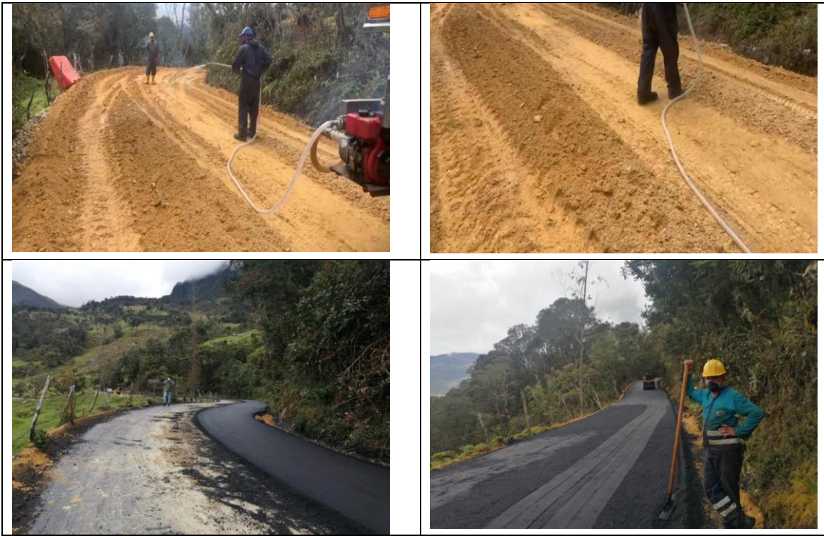
Frente de obra Animas Altas
