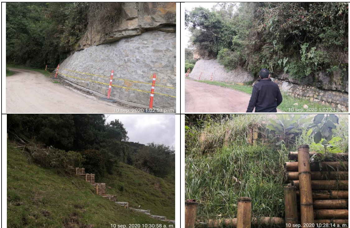
Frente de Obra: La Unión (Piedra pegada) y Frente de Obra: Santa Ana, manejo de Aguas.
