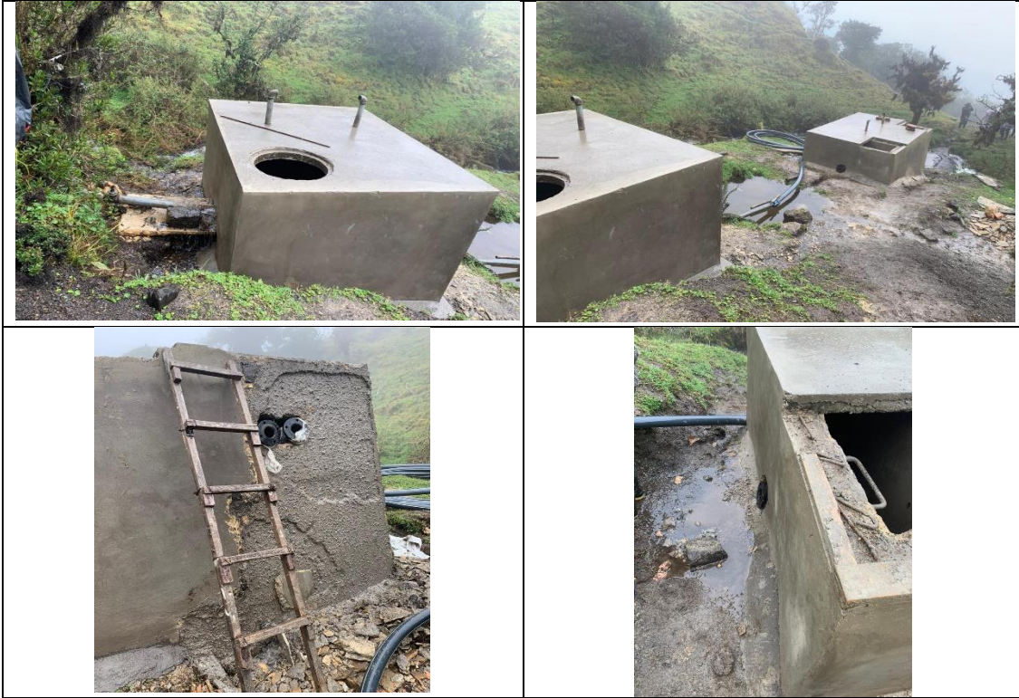
Frente de Obra: Acueducto de Jericó Rehabilitación de tanques y mantenimiento.
