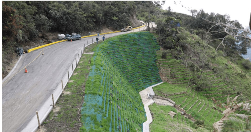
Muro de contención en suelo reforzado - vía La Unión
