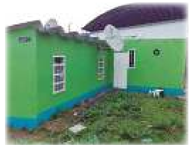
Salones comunales reciben reparación y mantenimiento. Salón Betania en la foto.
