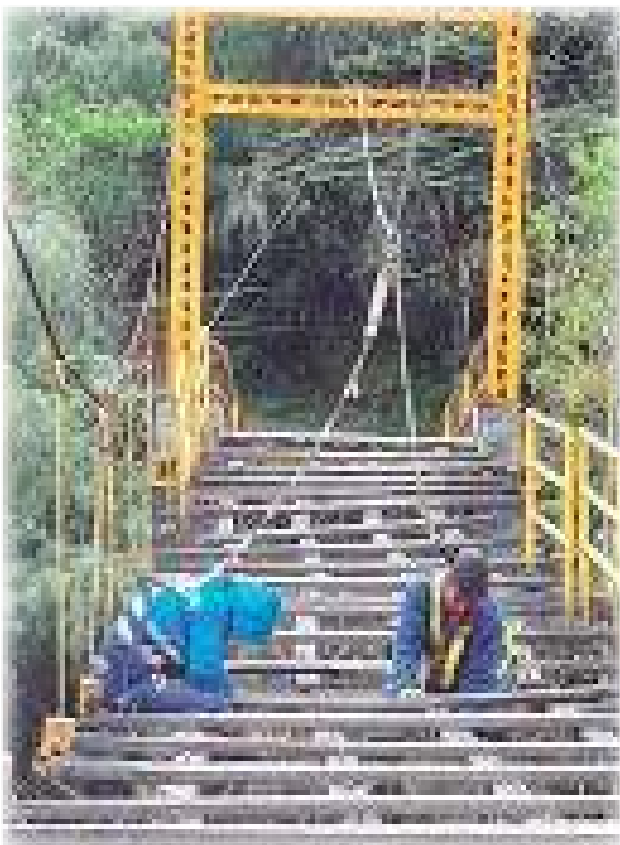
Mantenimiento del Puente Peatonal Sopas continúa con éxito.
