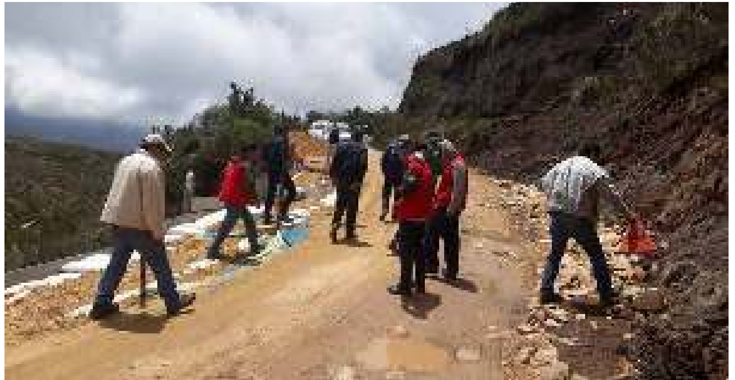
Equipo de Alcaldía Local inspeccionando labores de malla vial
